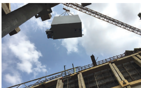
Großer Aufwand: Hier wird das tonnenschwere Strahlenschutz-Tor eingebaut. Foto: Oncocubus
