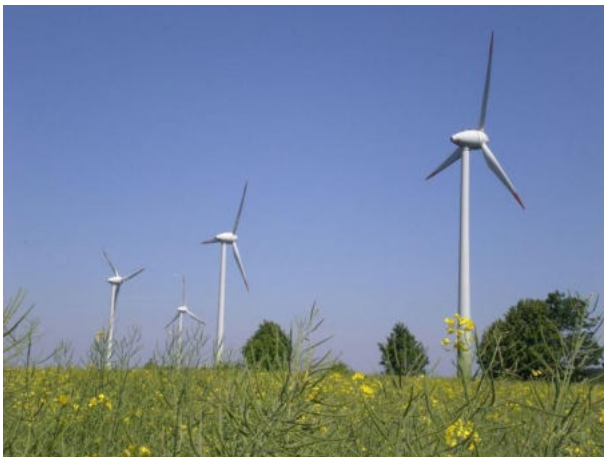
Abbildung 8-15: Windkraftnutzung im Bereich der Kuppenlage am Oerweg.
