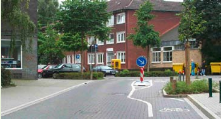
Baulich gesicherte Ausfahrt in der Hardtstraße
