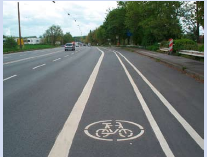
Radfahrstreifen mit Sicherheitsstreifen auf der Friedrich-Ebert-Straße
