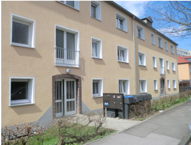
Abbildung 63:Seniorenwohngemeinschaft Arnsberg - Gebäude
